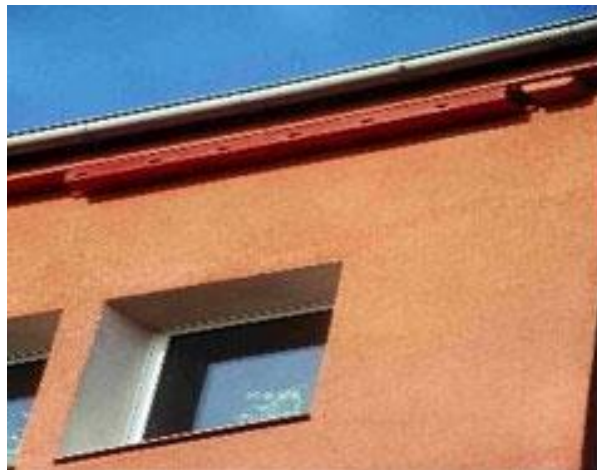
Abb. 5: Das Anbringen von Nistkästen kann heutzutage auch recht unauffällig erfolgen (Bildquelle: www.nabu-weimar.de/projekte/artenschutz/gebäudebrütterschutz )
