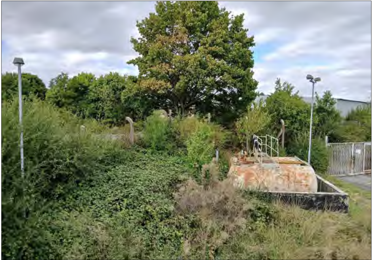
Abbildung 7 Blick auf das Eingangstor und die Öltanks innerhalb des PG (Foto: IBU 2025).
