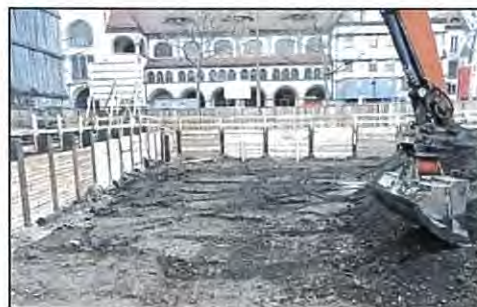
Abb. 4. Schichtenweiser Abtrag, verpflichtend bei baubegleitender KMR
